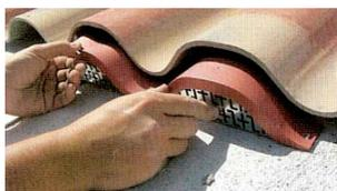
Aucune, se glisse sous la plaque sous-tuile. Le Protège Combles sera bloqué par le tire fond, sans que le poids de la plaque porte sur lui.
